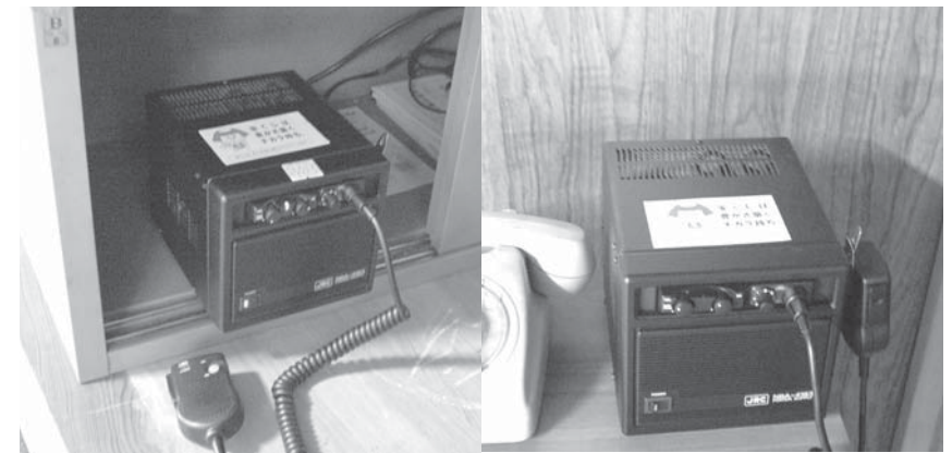
2.苗代田地区(左)、3.福浦地区(右)：無線式区長放送設備整備
